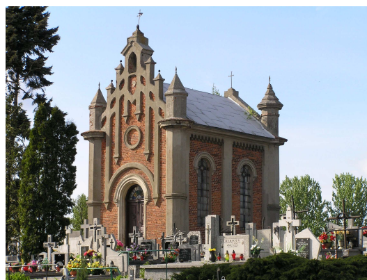
Kaplica cmentarna w Starych Proboszczewicach.
