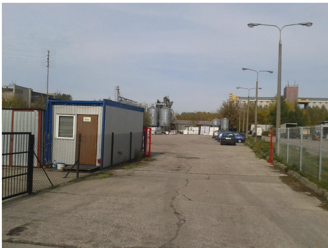
Zdjęcie 6. Niezagospodarowany teren przy budynku socjalnym w Ogorzelicach
