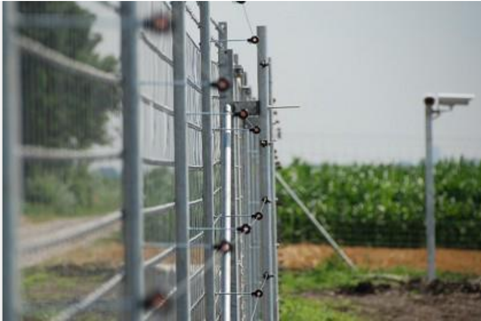
Zdjęcie 6 Przykładowe ogrodzenie farmy fotowoltaicznej
