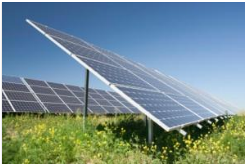
Zdjęcie 7 Sposób montażu paneli fotowoltaicznych na stelażach wbijanych bezpośrednio do gruntu.
