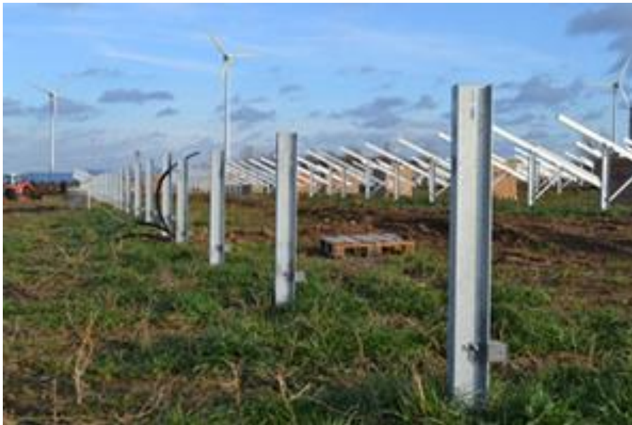
Zdjęcie 8 Profile metalowe: podstawowy element konstrukcji.
