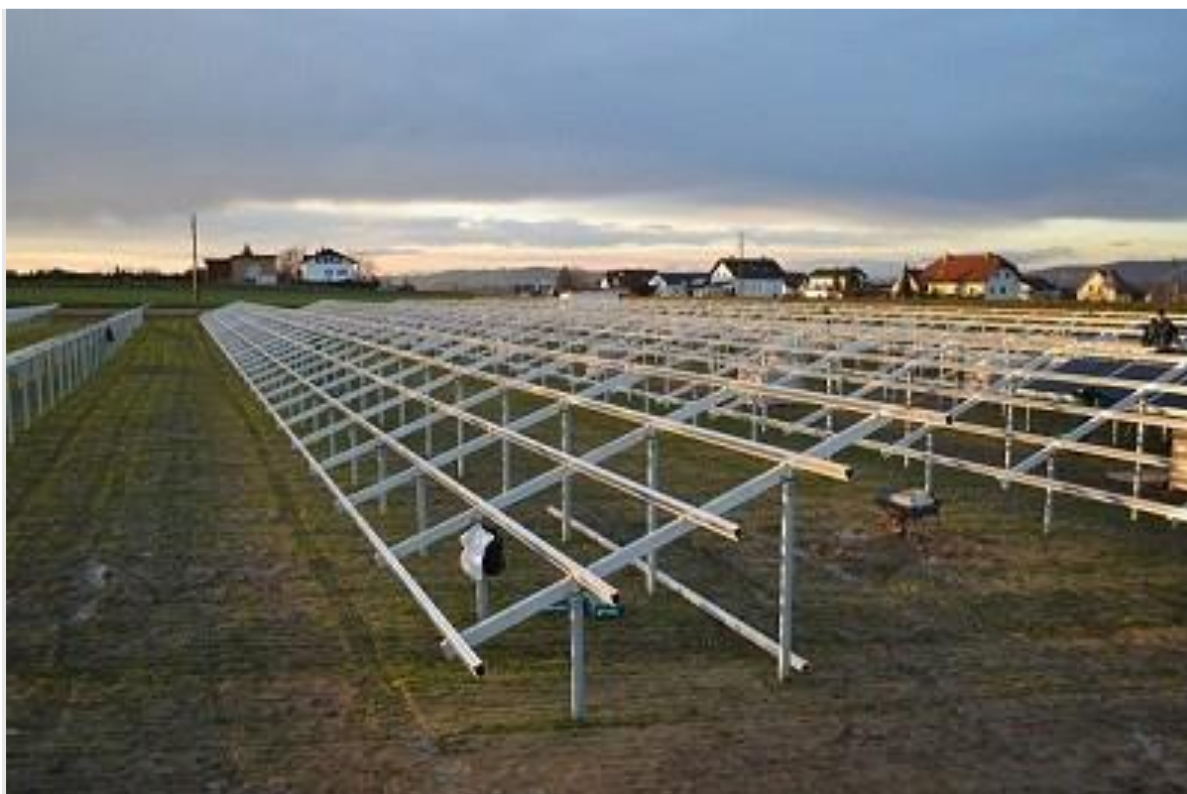
Zdjęcie 11 Szkielety przed montażem paneli, farma solarna NIENBURG 4 MW (Niemcy) (Remor Solar).
