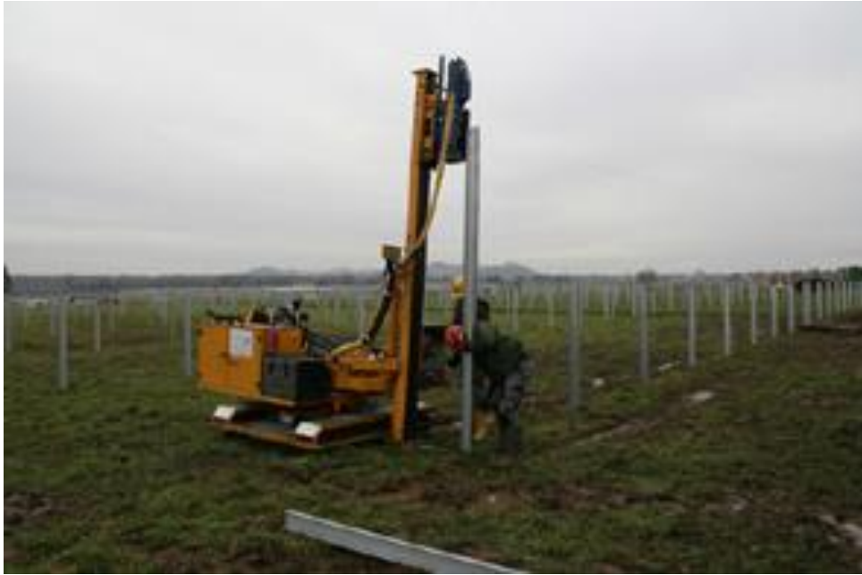
Zdjęcie 9 Montaż profili na potrzeby realizacji farmy fotowoltaicznej.
