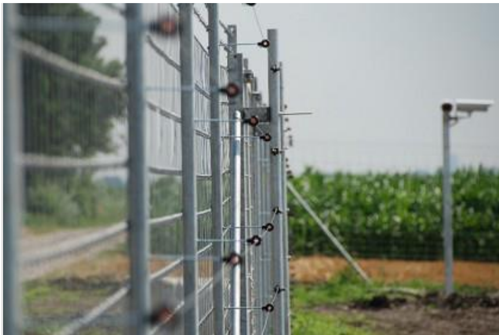
Zdjęcie 6 Przykładowe ogrodzenie farmy fotowoltaicznej
