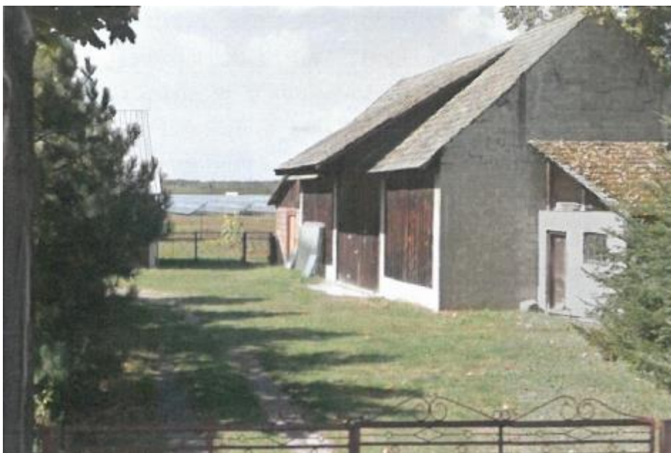
Zdjęcie 20 Widok na instalację fotowoltaiczną z odległości ok. 140 m.
