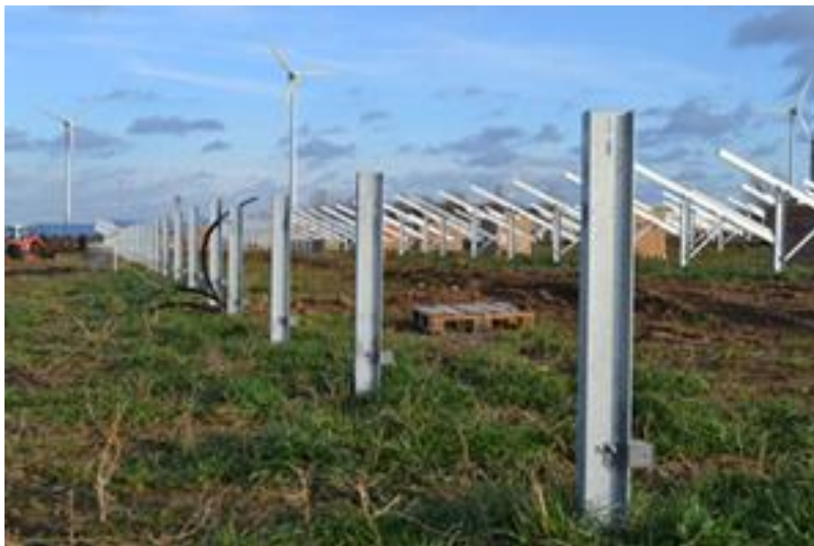
Zdjęcie 8 Profile metalowe: podstawowy element konstrukcji.
