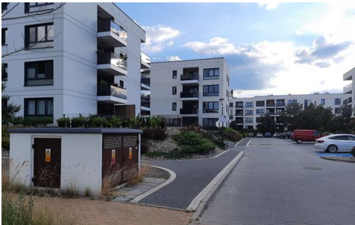
Zdjęcie 13 Standardowa stacja kontenerowa w otoczeniu zabudowy.
