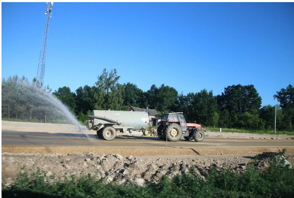
Fotografia 3 Zraszanie dróg dojazdowych w celu ograniczenia pylenia
