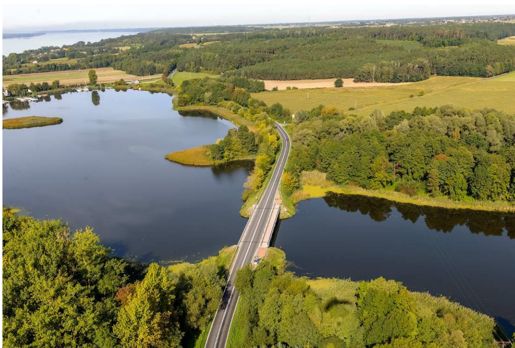
Fotografia 2 Most nad Skrwą w ciągu drogi istniejącej
