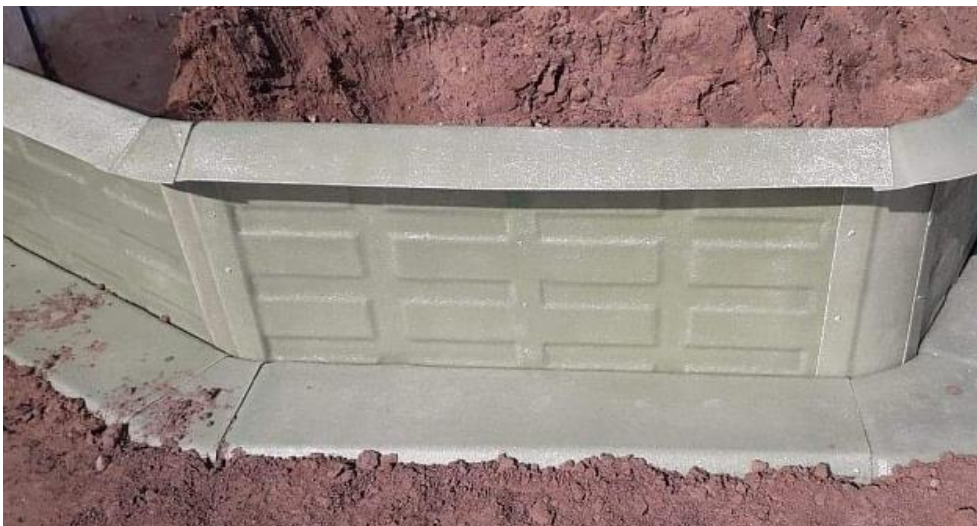
Fotografia 13 Przykład wykonania ogrodzenia ochronno-naprowadzającego z laminatu
