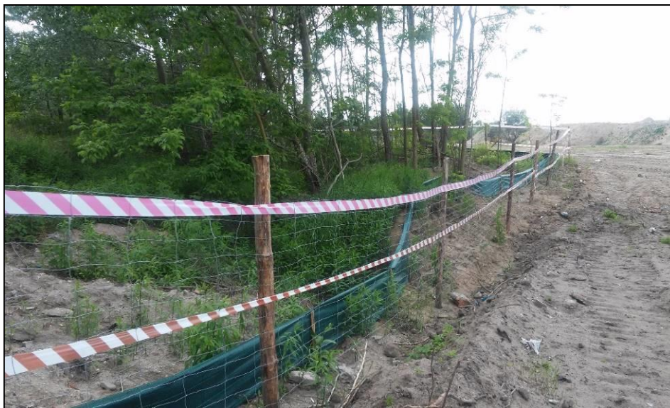
Fotografia 11 Przykład wykonania tymczasowych wygradzeń dla płazów
