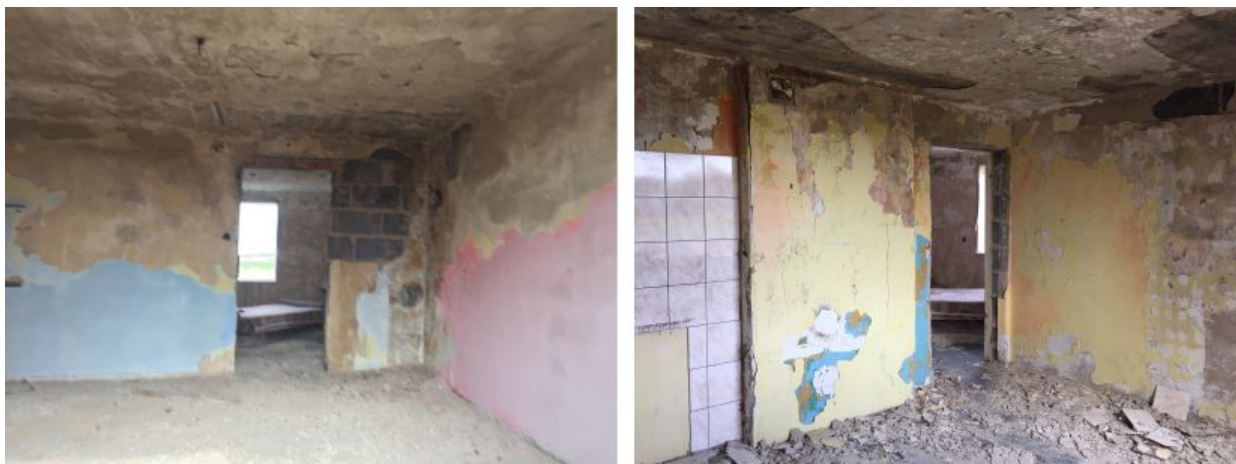
Fotografie 1-2 Wnętrze pustostanu w północnej części inwestycji.
