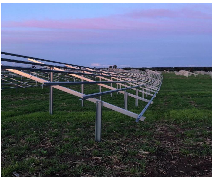
Ryc. nr 7: Przykładowe Szkielety przed montażem paneli
