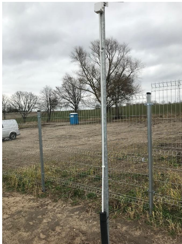
Ryc. nr 13 Przykładowe ogrodzenie farmy fotowoltaicznej
