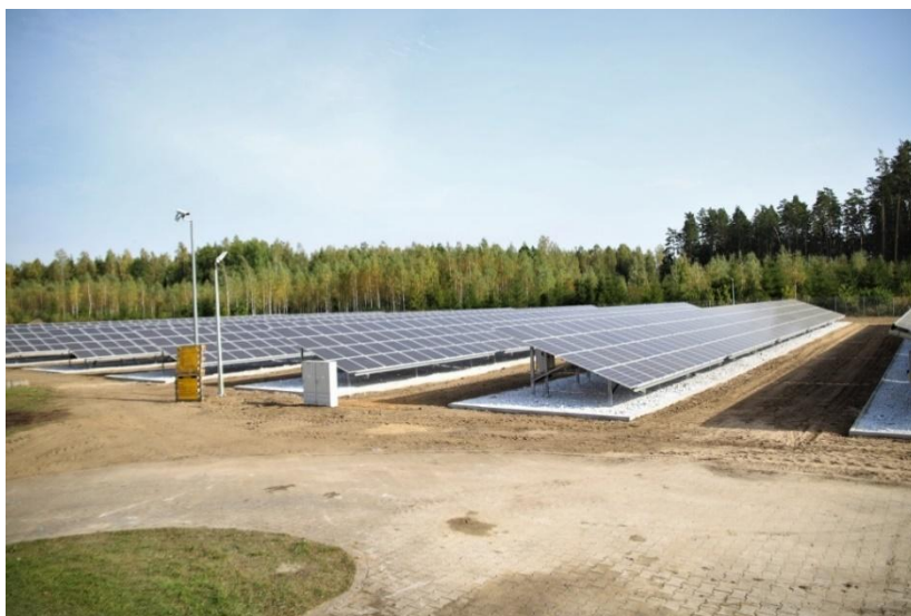
Ryc. nr 25 Przykładowe wyścielenie grysem powierzchni pod panelami bifacialnymi w miejscowości Przykopce w gm. Ełk. Obszar pomiędzy obrzeżami grysowej wyściółki może zostać pokryty murawą. (źródło: https://investin.elk.pl/aktualnosci-wpis/4576/energia-sloneczna-zasila-stacje-uzdatniania-wody-dla-elku )
