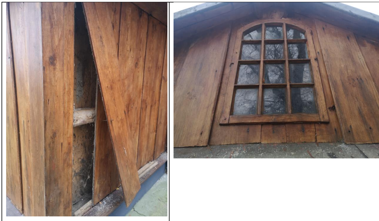
Fot.5.4. Miejsce wykonania odkrywki ściany szkieletowej.
