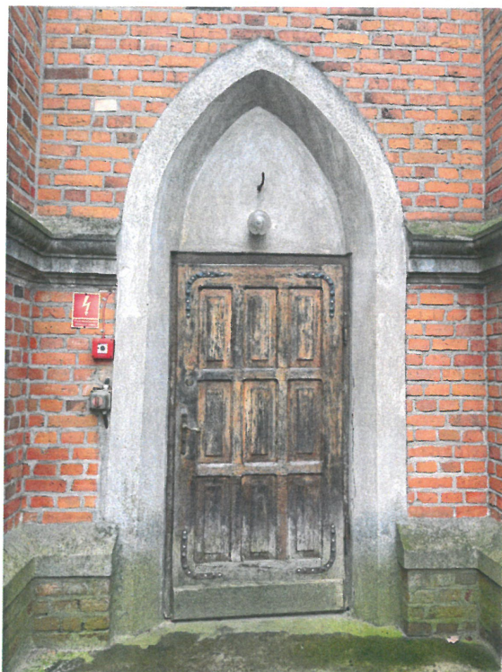
Drzwi (nr 3), elewacja wschodnia
