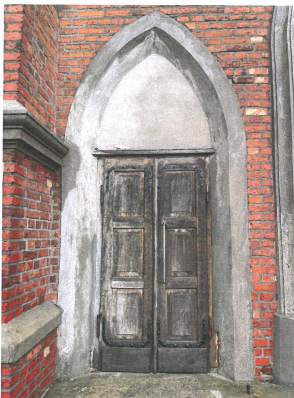
Drzwi (nr 2), elewacja zachodnia
