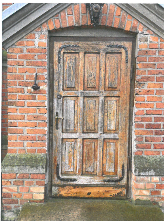
Drzwi (nr 4), elewacja wschodnia
