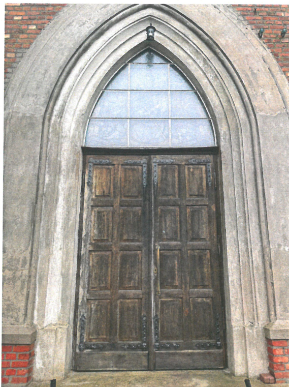
Drzwi główne (nr 1), elewacja zachodnia
