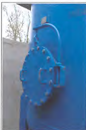
Zdjęcie 2. Winda i zawiasy umożliwiające łatwą obsługę filtra
