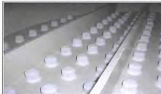
Zdjęcie 1. Wzmocnienie dna drenażowego w filtrach ciśnieniowych z płaskim dnem grzybkowym
