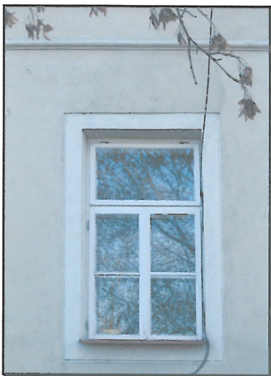
Zdj.13 Drewniane okno prostokątne z górnym nadświetłem odchylnym i pojedynczym szprosem poziomym w skrzydłach rozwieranych.
