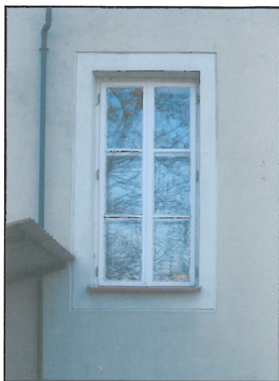
Zdj.14 Drewniane okno prostokątne z podwójnymi szprosami poziomymi w skrzydłach rozwieranych.
