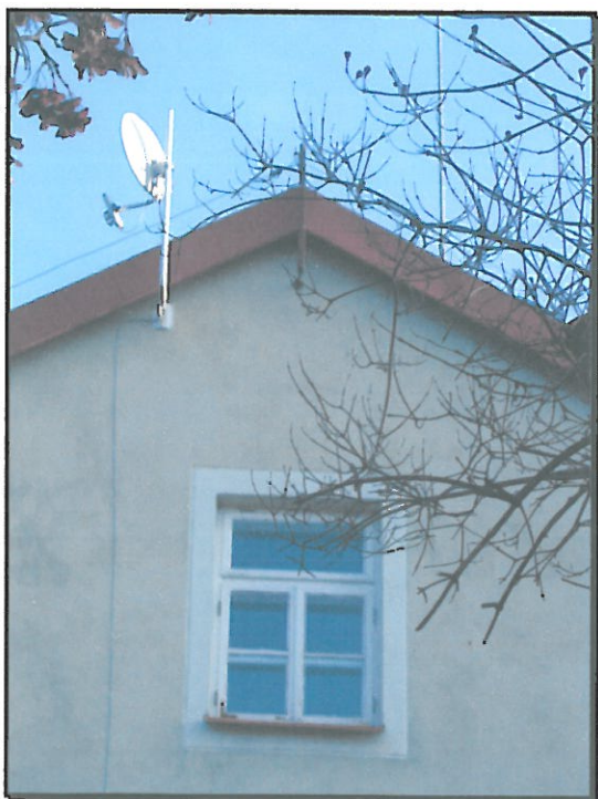
Zdj.15 Drewniane okno strychowe elewacji bocznych z górnym nadświetłem odchylnym i pojedynczym szprosem poziomym w skrzydłach rozwieranych.
