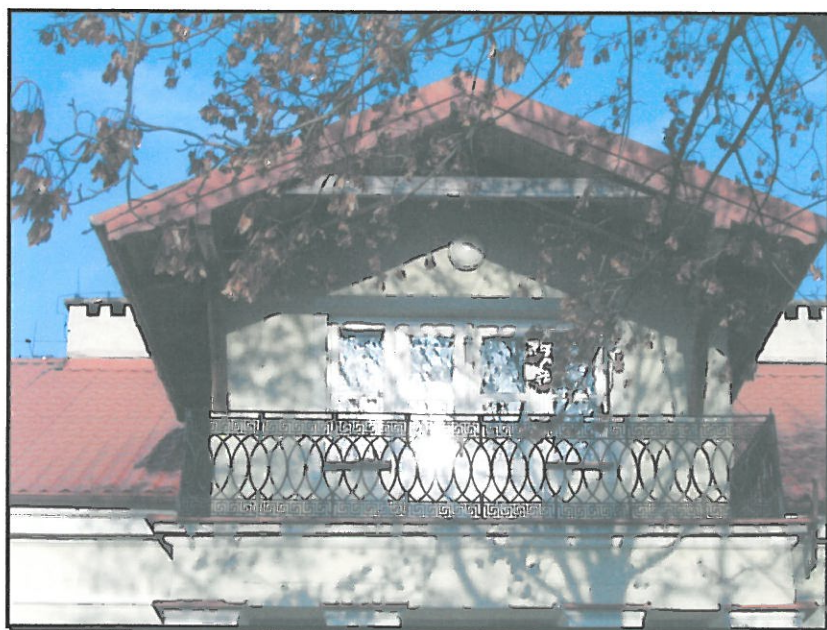
Zdj.7 Okap nad balkonem portyku. Ażurowa, kuta balustrada.
