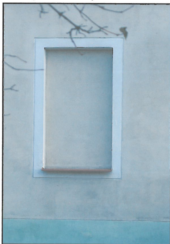
Zdj.16 Blenda o wymiarach okna zastosowanego w elewacji zachodniej.
