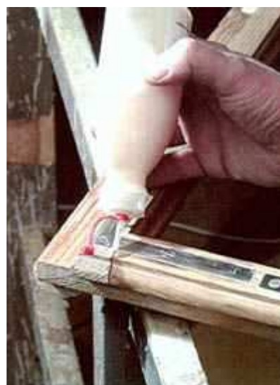
Wypełnianie pęknięć stolarki masą klejową.
