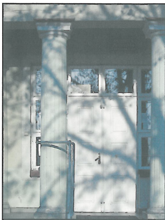
Zdj.11 Frontowe drzwi zewnętrzne, dwuskrzydłowe, pełne ze skrzydłami trójpłycinowymi, naświetlem górnym i naświetlami bocznymi.
