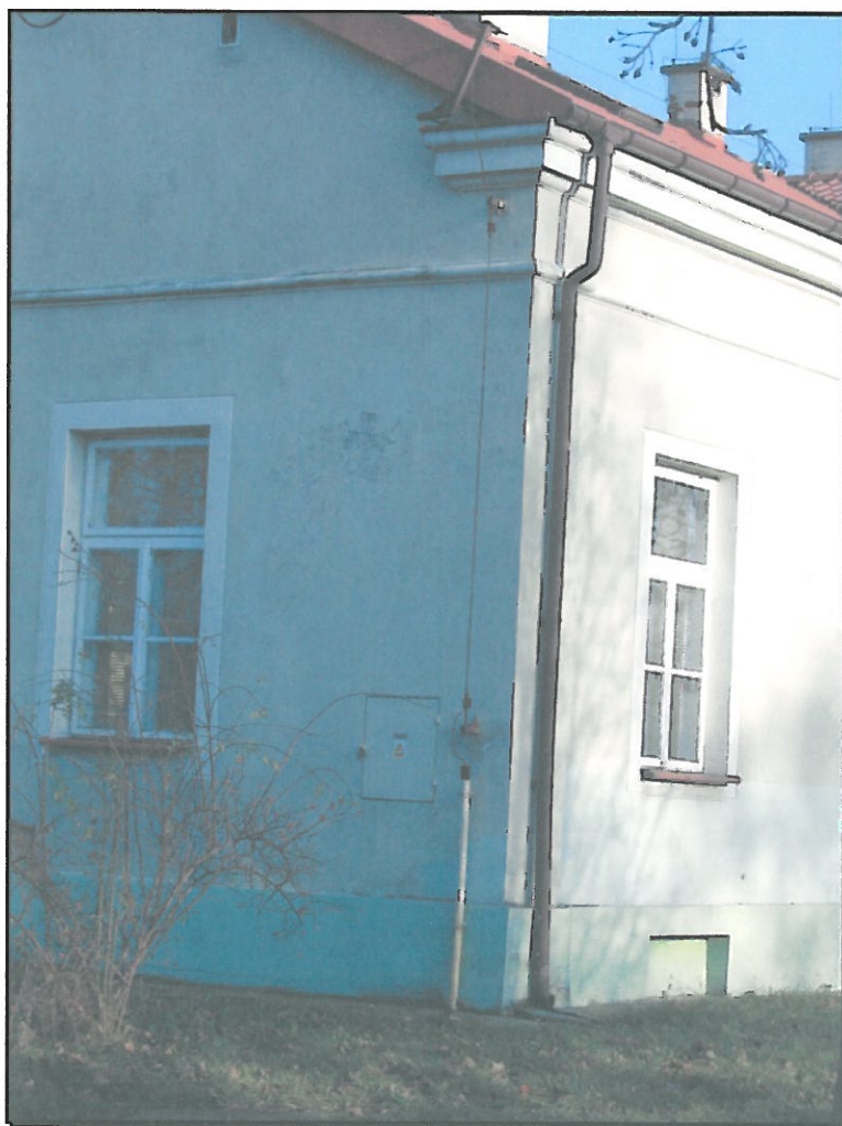
Zdj.8 Gzyms wieńczący ze zredukowanym belkowaniem oraz półeczka opaskowa. Od dołu gzyms cokołowy z blendą piwniczną.
