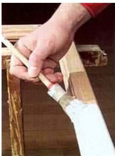
Malowanie gruntownie oczyszczonej stolarki.
