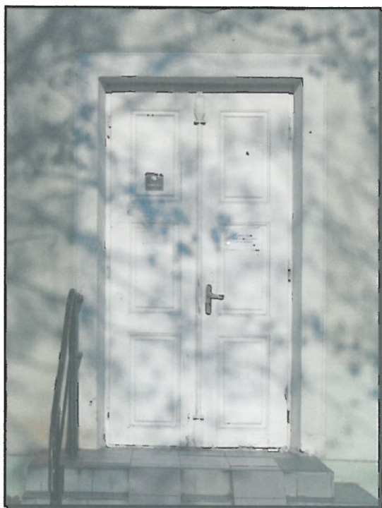
Zdj.10 Frontowe drzwi zewnętrzne, dwuskrzydłowe, pełne ze skrzydłami trójpłycinowymi.
