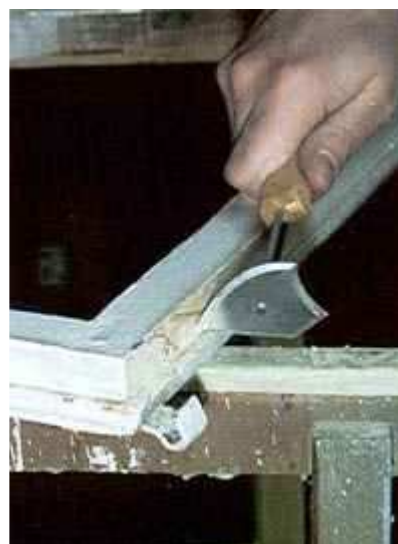
Usuwanie zgrubień farby specjalnym narzędziem.
