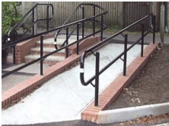
Rys.3 Układ poręczy montowany przy pomocy systemu EuroClamp.
