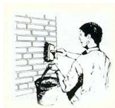
Rys. 26 Impregnacja pędzlem
