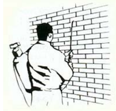
Rys. 27 Impregnacja metodą natryskową
