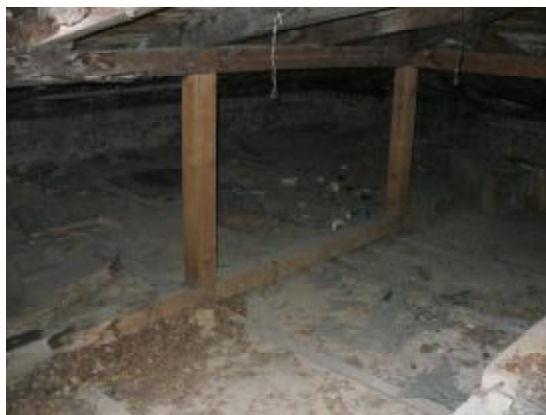
Fot. Nr 6 Układ belek stropowych z dwuteowników (na obniżonym stropie)
