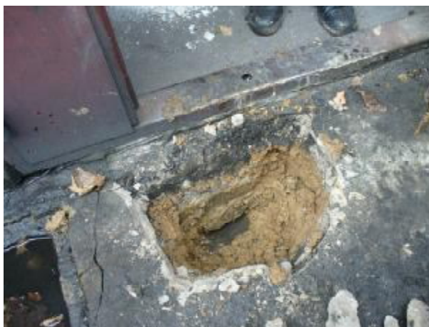
Fot. Nr 5 Odkrywka nr 3 – ławy fundamentowe zewnętrzne
