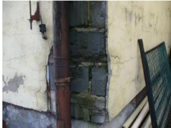
Fot. Nr 9 Ściana nadziemia nad cokołem
