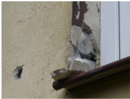
Fot. Nr 11 Gazobeton ocieplający na filarkach międzyokiennych
