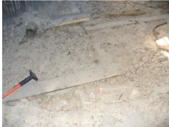
Fot. Nr 7 Oparcia belek stalowych na ścianie wewnętrznej z przesunięciem
