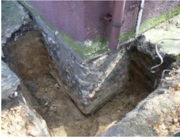
Fot. Nr 4 Widok ściany fundamentowej w odkrywce nr 2
