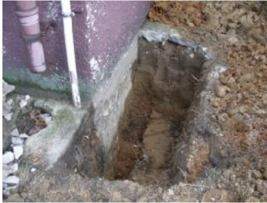
Fot. Nr 2 Ściana fundamentowa w odkrywce nr 1
