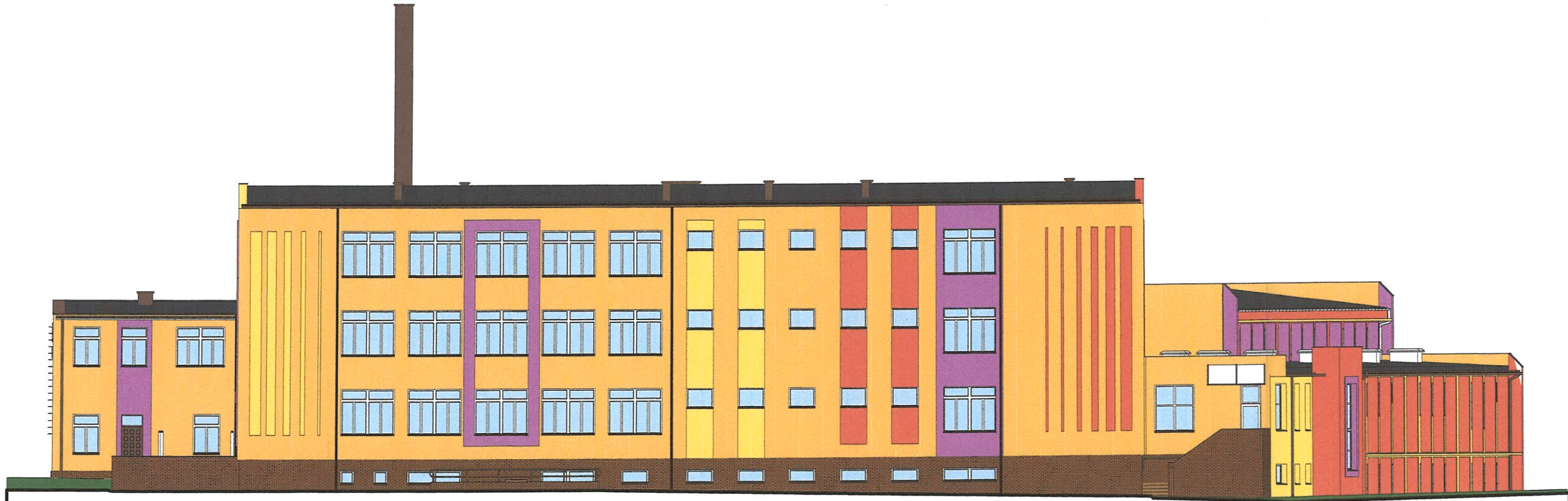
STAN PO TERMOMODERNIZACJI
