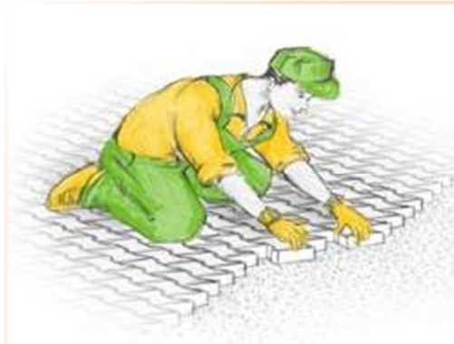
Rys.16 Układanie kostki brukowej.
