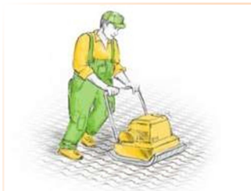
Rys.17 bijanie powierzchni.
