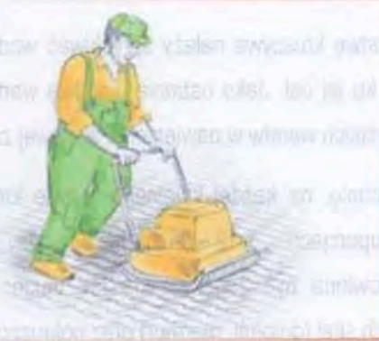
Rys.13 Ubijanie powierzchni.
