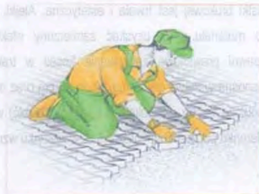
Rys.12 Układanie kostki brukowej.
