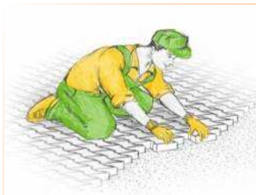
Rys.12 Układanie kostki brukowej.
