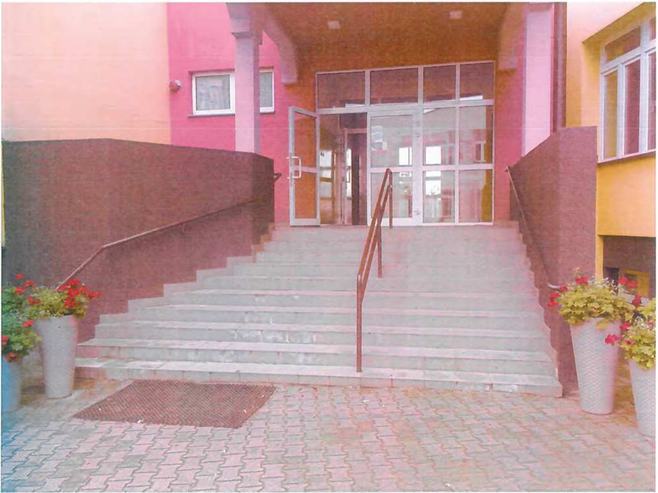
Wejście główne do budynku szkoły.
