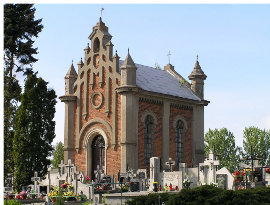
Kaplica cmentarna w Starych Proboszczewicach.
