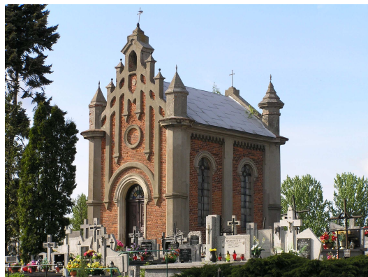
Kaplica cmentarna w Starych Proboszczewicach.
