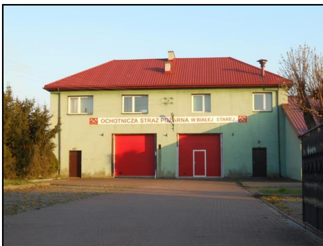
Fot. 13. Budynek Ochotniczej Straży Pożarnej w Starej Białej. Fot. G. Ferliński.
