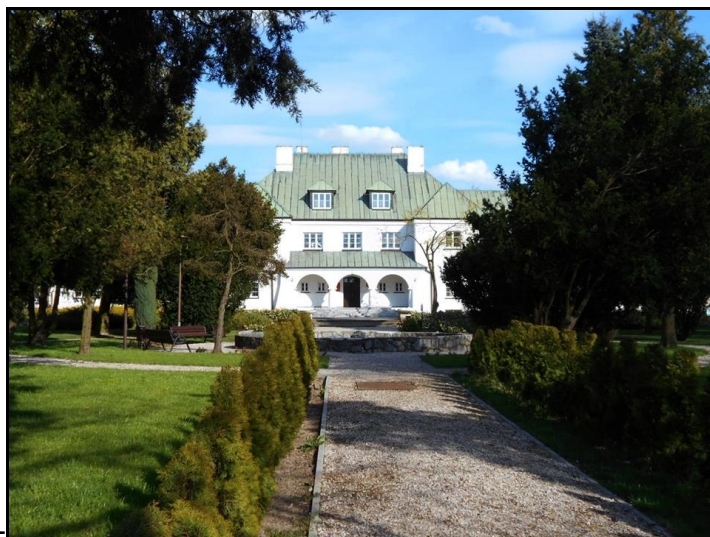
Fot. 1. Budynek szkoły wraz z otaczającym drzewostanem w Nowym Trzepowie, wpisane do rejestru zabytków rej. nr 501 z dnia 01.06.1979 r. Fot. G. Ferliński.
