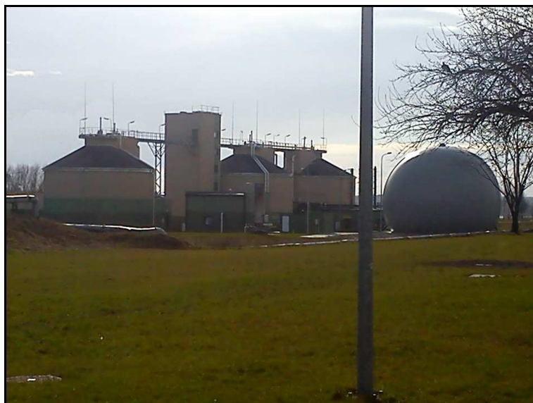
Fot. 14. Oczyszczalnia ścieków w Maszewie. Fot. A. Woźniak.
