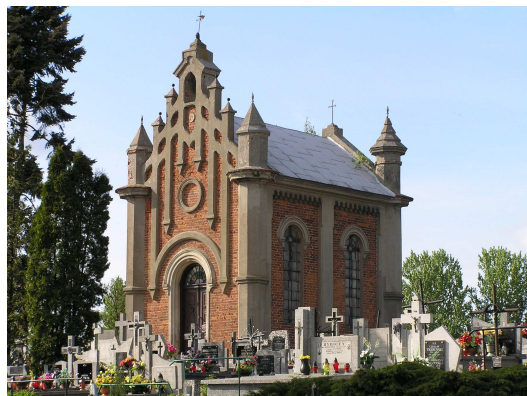
Kaplica cmentarna w Starych Proboszczewicach.
