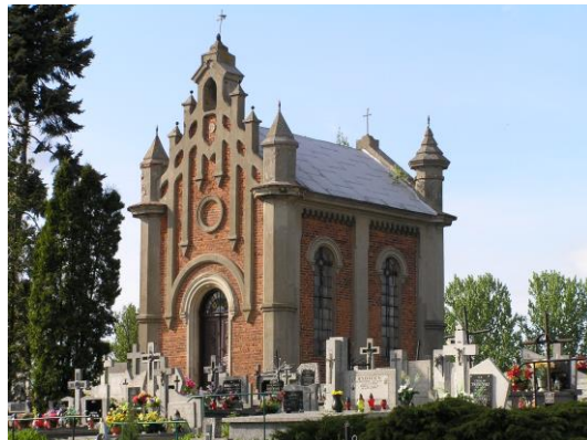
Kaplica cmentarna w Starych Proboszczewicach.
